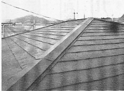
一般住宅の施工例
